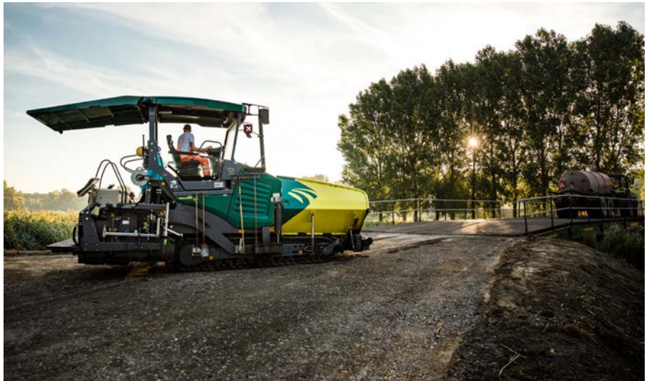
Op de Trekvogelweg in Almere is duurzaam asfalt toegepast.
